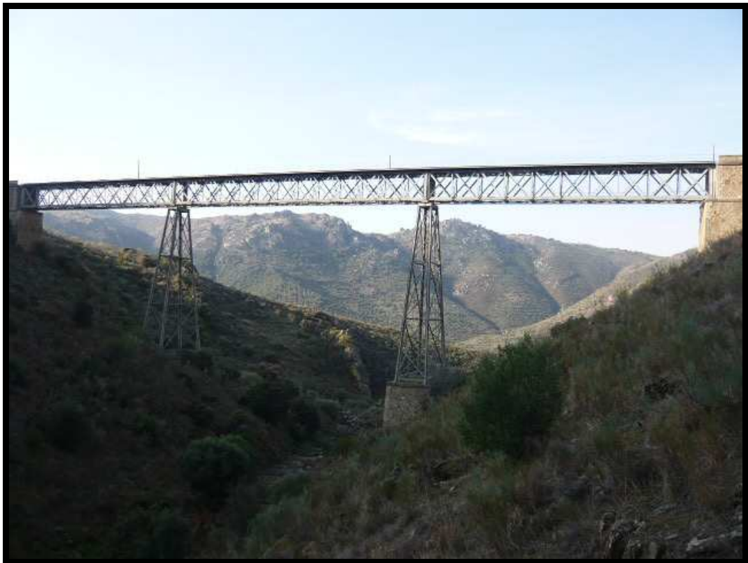
Kilómetro 72,3 PUNTE 9 SOBRE EL ARROYO LOS POYOS (135 metros lineales)
