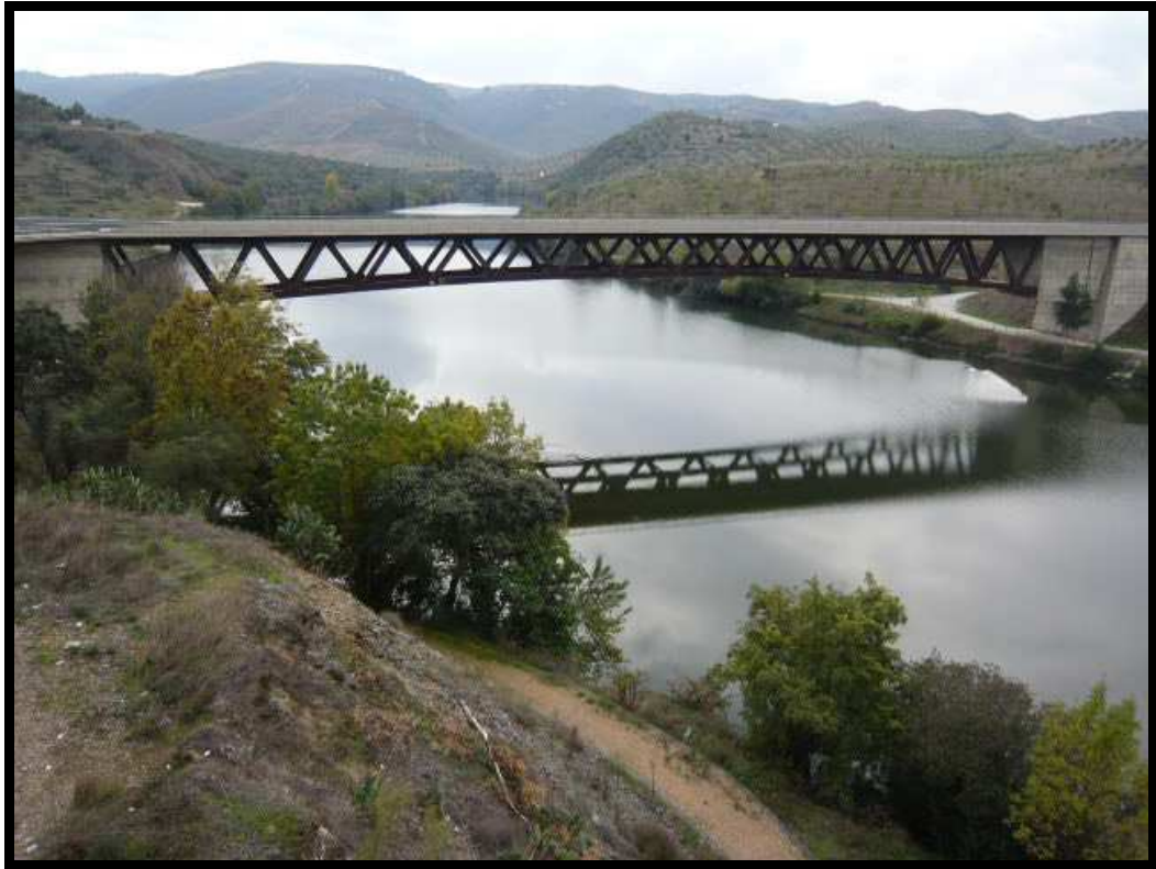
PUENTE 13+1 DE LA CARRETERA (143 metros lineales)
