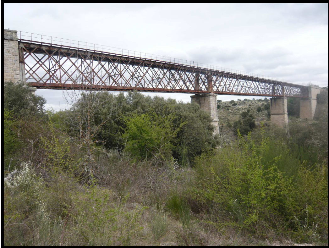
Kilómetro 18,2 PUENTE 1 SOBRE EL RÍO YELTES (157 metros lineales)
