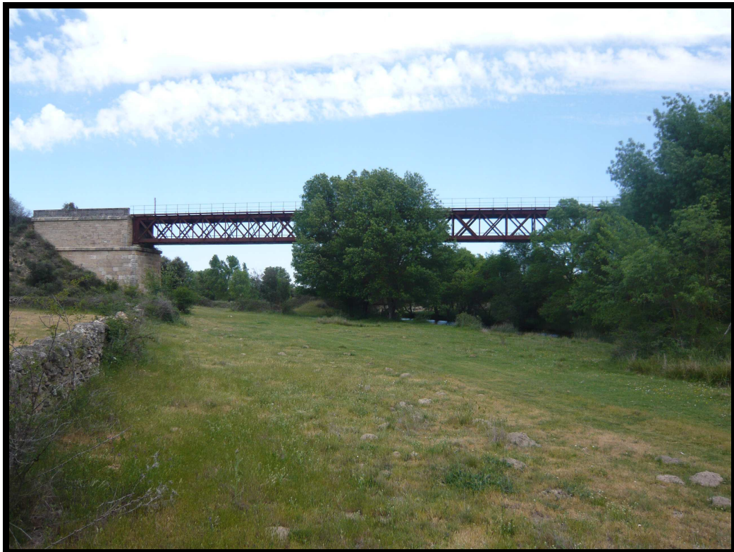
Kilómetro 39,6 PUENTE 2 SOBRE EL RÍO CAMACES (60 metros lineales)
