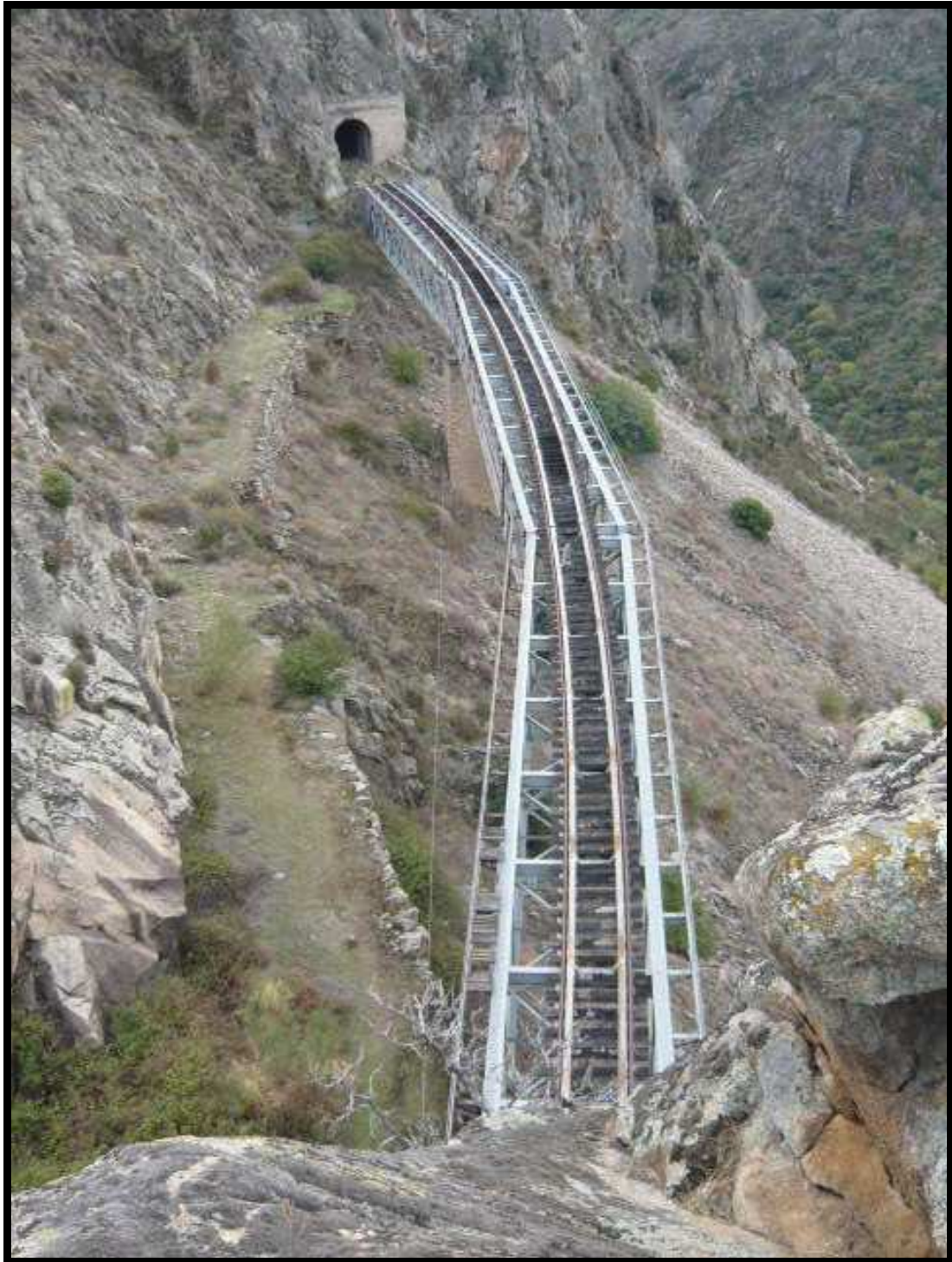
Kilómetro 67,5 PUENTE 7 SOBRE EL ARROYO POYO VALIENTE (138 metros lineales, en curva)
