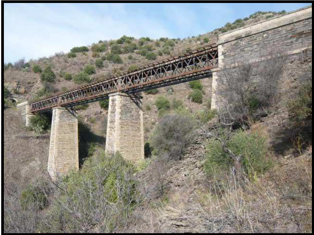
Kilómetro 73,8 PUNTE 10 SOBRE EL ARROYO LOS RISCOS (71 metros lineales)
