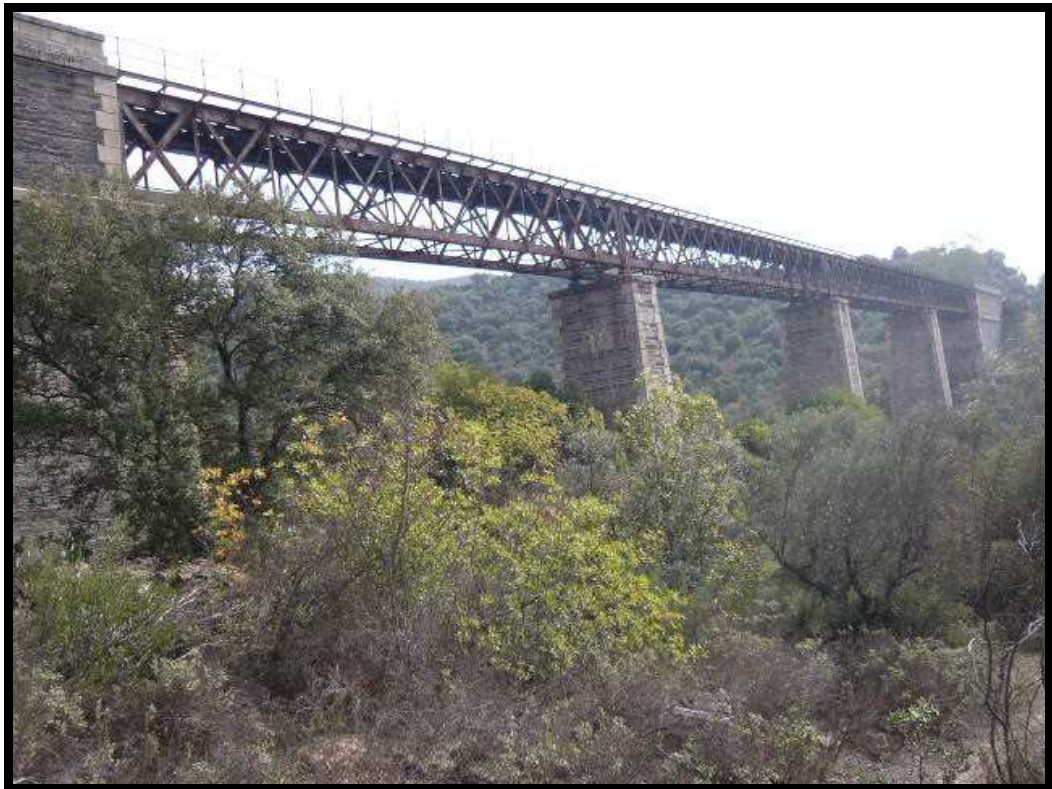
Kilómetro 76,5 PUNTE 11 SOBRE EL ARROYO LAS ALMAS (133 metros lineales)
