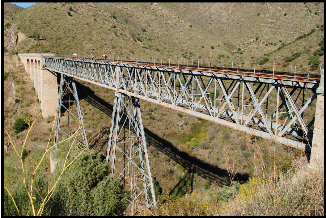
Kilómetro 70,7 PUNTE 8 SOBRE EL ARROYO EL LUGAR (140 metros lineales)
