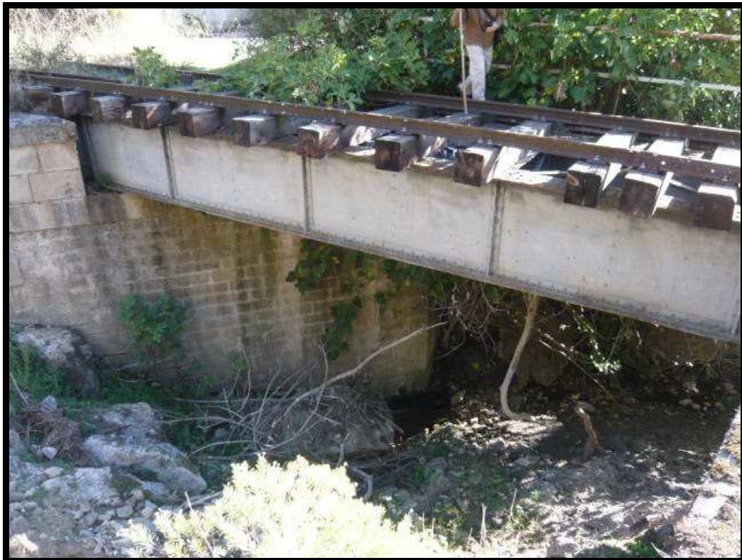
Kilómetro 63,2 PUEBTE 4 SOBRE EL RÍO PINGALLO (11 metros lineales)
