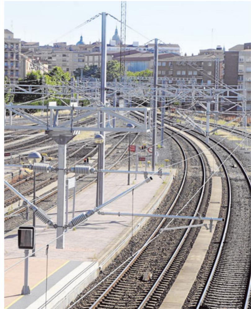
La nueva catenaria instalada para la electrificación del tramo entre Medina del Campo y Salamanca. | BARROSO
